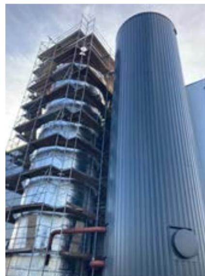
Die beiden neuen Energiespeicher während der Isolierungsarbeiten
