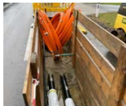
Fernwärmekünette mit Fernwärmerohren und der Leerverrohrung für Glasfaser-Internet
