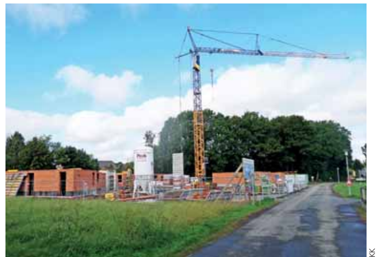
An der Entstehung der „Thermenresidence“ am Stadtrand von Bad Radkersburg wird schon seit mehreren Wochen eifrig gearbeitet.
