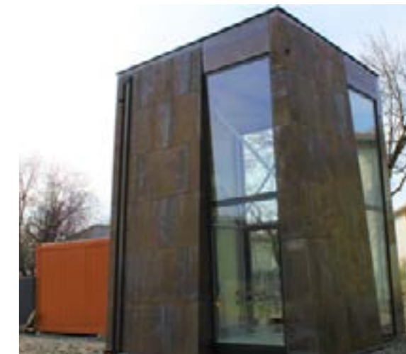
Technikzentrale und Sicherheitsbohrung der Stadtquelle Bad Radkersburg im Stadtpark
